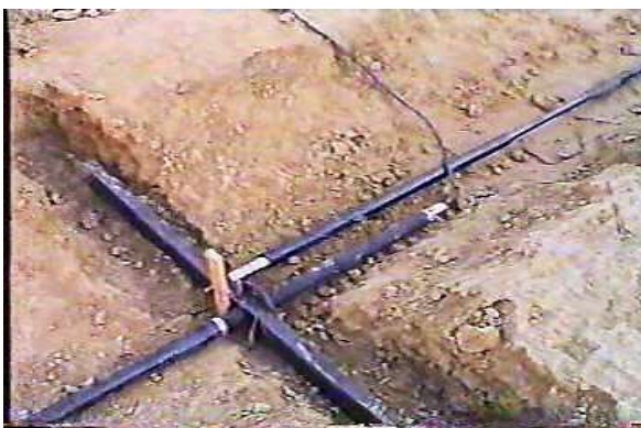
شکل ۸: نحوه کارگذاری کرنش سنج‌ها در بدنه سد
