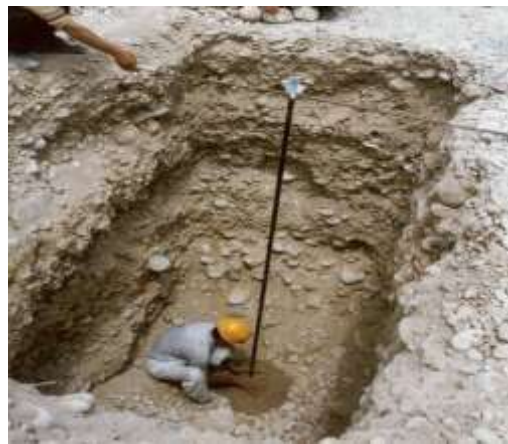
شکل ۹: نصب پیزومتر لوله‌ای قائم
