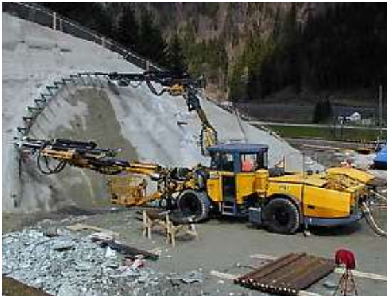
شکل ۳: لوله فورپولینگ و روش نصب آن [۱۰]
