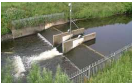
شکل ۱: یک نوع سرریز کرامپ در مسیر کانال برای اندازه‌گیری دبی جریان
