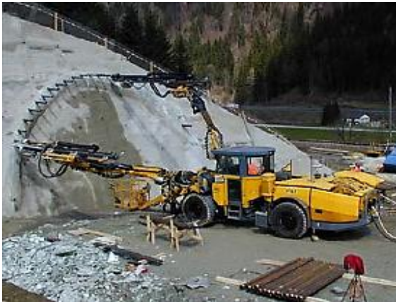
شکل ۳: لوله فورپولینگ و روش نصب آن [۱۰]
